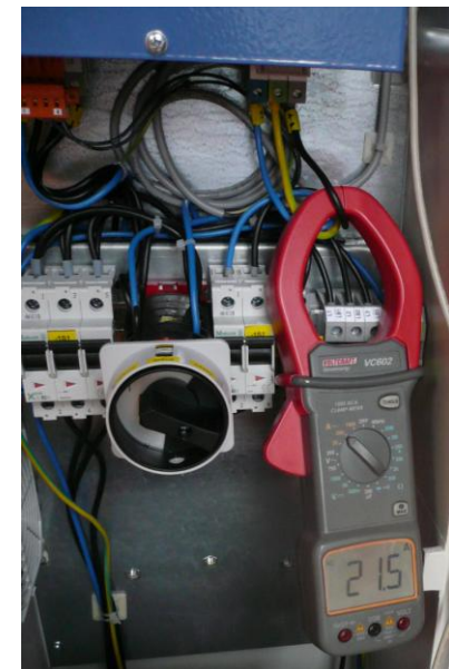
Abbildung 13 Strommessung an LB
