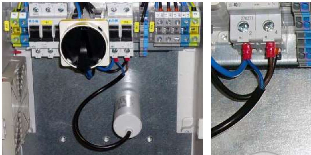
1-3: Klemmleiste mit Kompensationskondensator für Trassenkompensation
